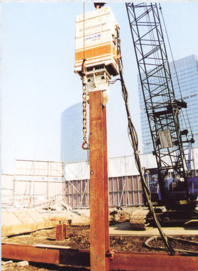
品川駅前のH鋼杭打込み
