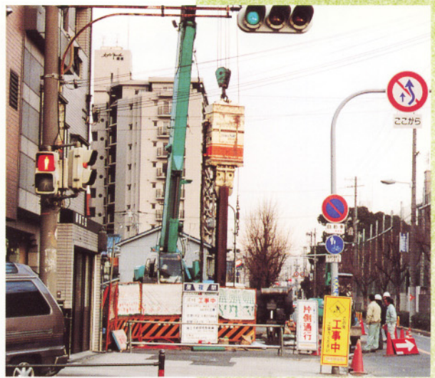
市街地でのH鋼杭打込み
